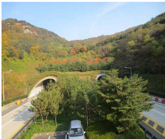
시점부 절토사면 전경
