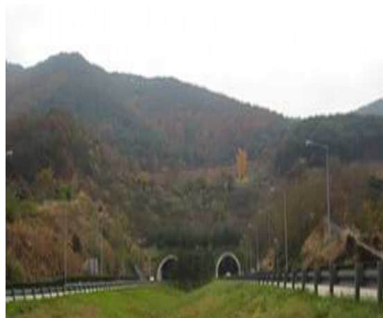
종점부 절토사면 전경
